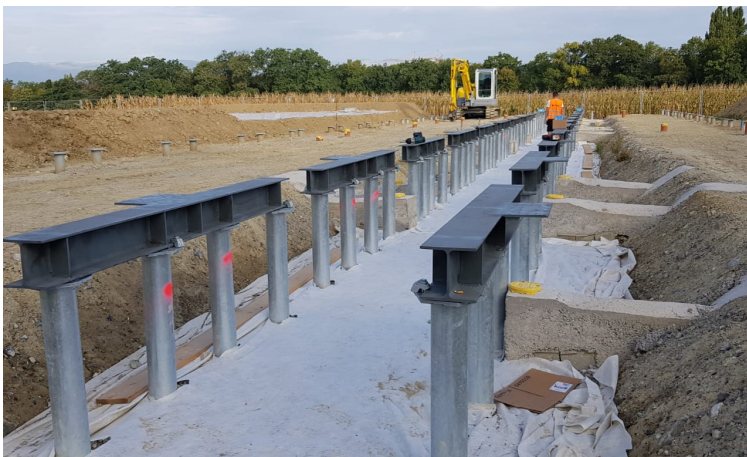
Montierte Stahlprofile als Auflage
